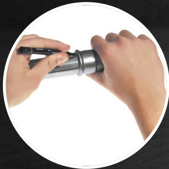
**05** | Отметка глубины ввода трубы в фитинг - необходимое условие для получения надежного соединения.
