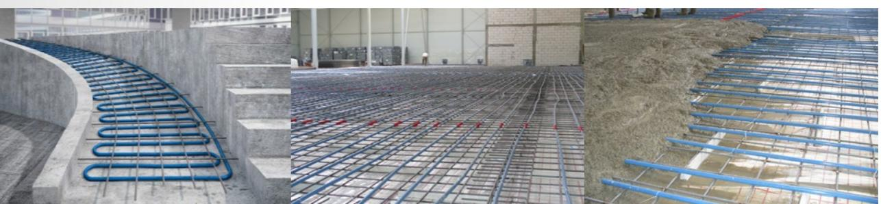
Система KAN-therm для панельного отопления/охлаждения
