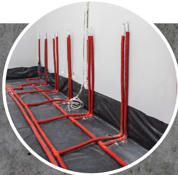
**01** Перед монтажом несущей конструкции следует выполнить подводку разводящих трубопроводов к греющим/охлаждающим панелям. Также необходимо предусмотреть и установить другое оборудование, которое должно быть проложено за несущей конструкцией, например, электрическое, канализационное и т.п.
