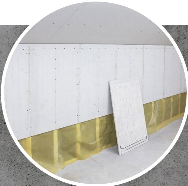
**04** Греющие/охлаждающие панели следует склеивать между собой, чтобы получить монолитную конструкцию.
