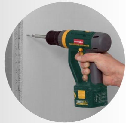
Крепление самонарезающими винтами /саморезами к стальной или деревянной несущей конструкции.
