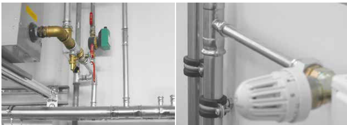
Примеры монтажа оборудования KAN-therm Steel
