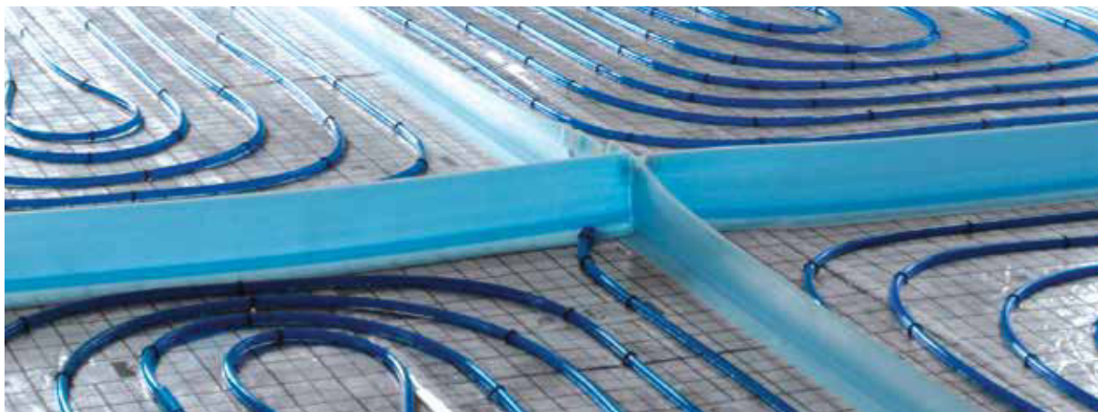
Рис. 14. Деление греющей поверхности разделительными швами.
