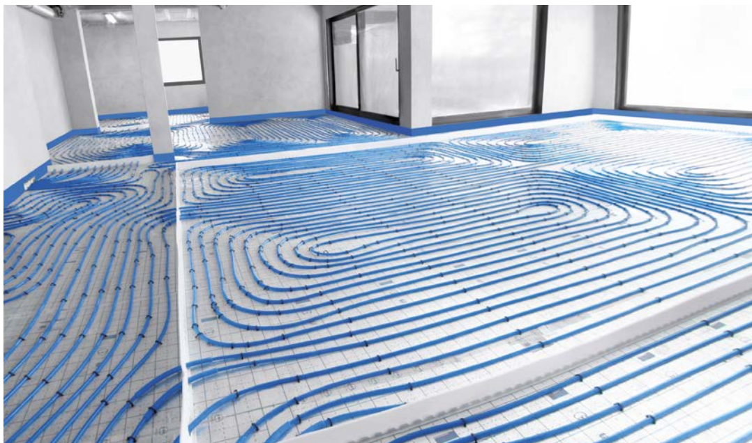
Рис. 24. Напольное отопление, выполненное в системе KAN-therm Tacker
