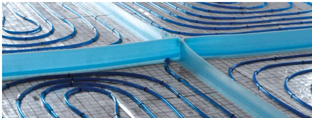
Рис. 13. Деление греющей поверхности разделительными швами
