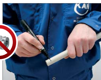
2. Отметь глубину сварки.
