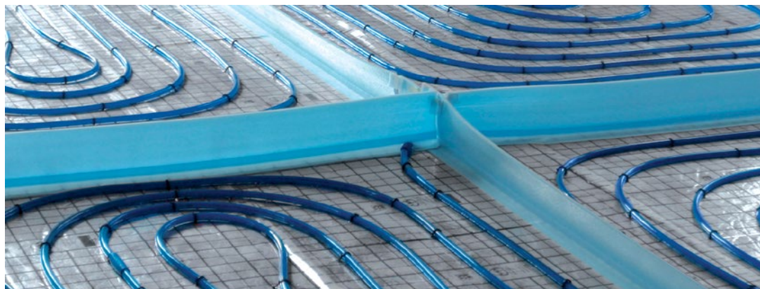
Рис. 13. Деление греющей поверхности разделительными швами
