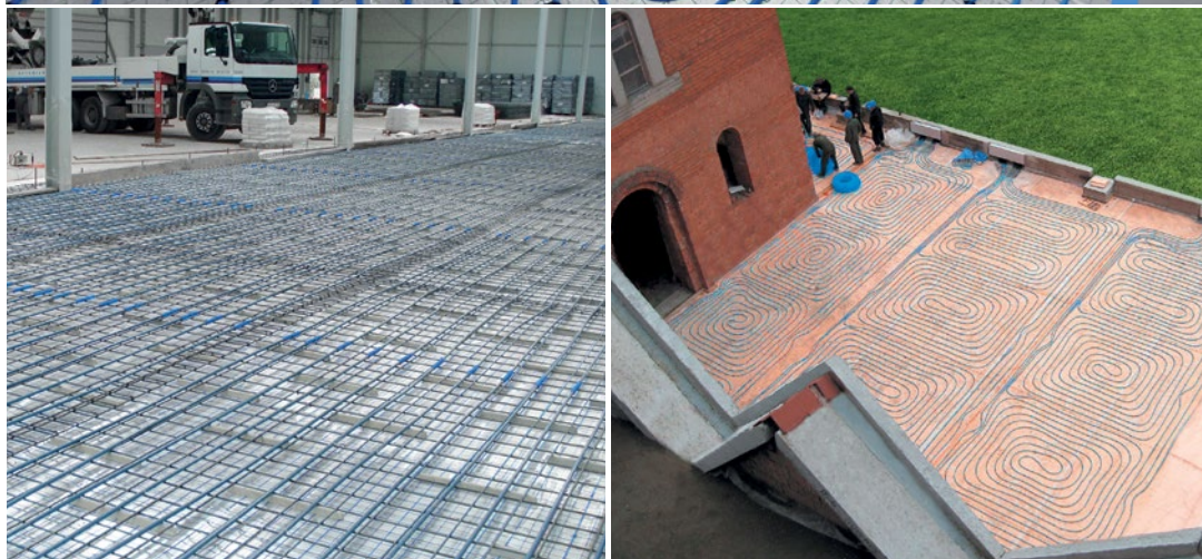
Рис. 4. Система напольного отопления в складском помещении при использовании труб PE-RT Blue Floor и системы KAN-therm NET.
