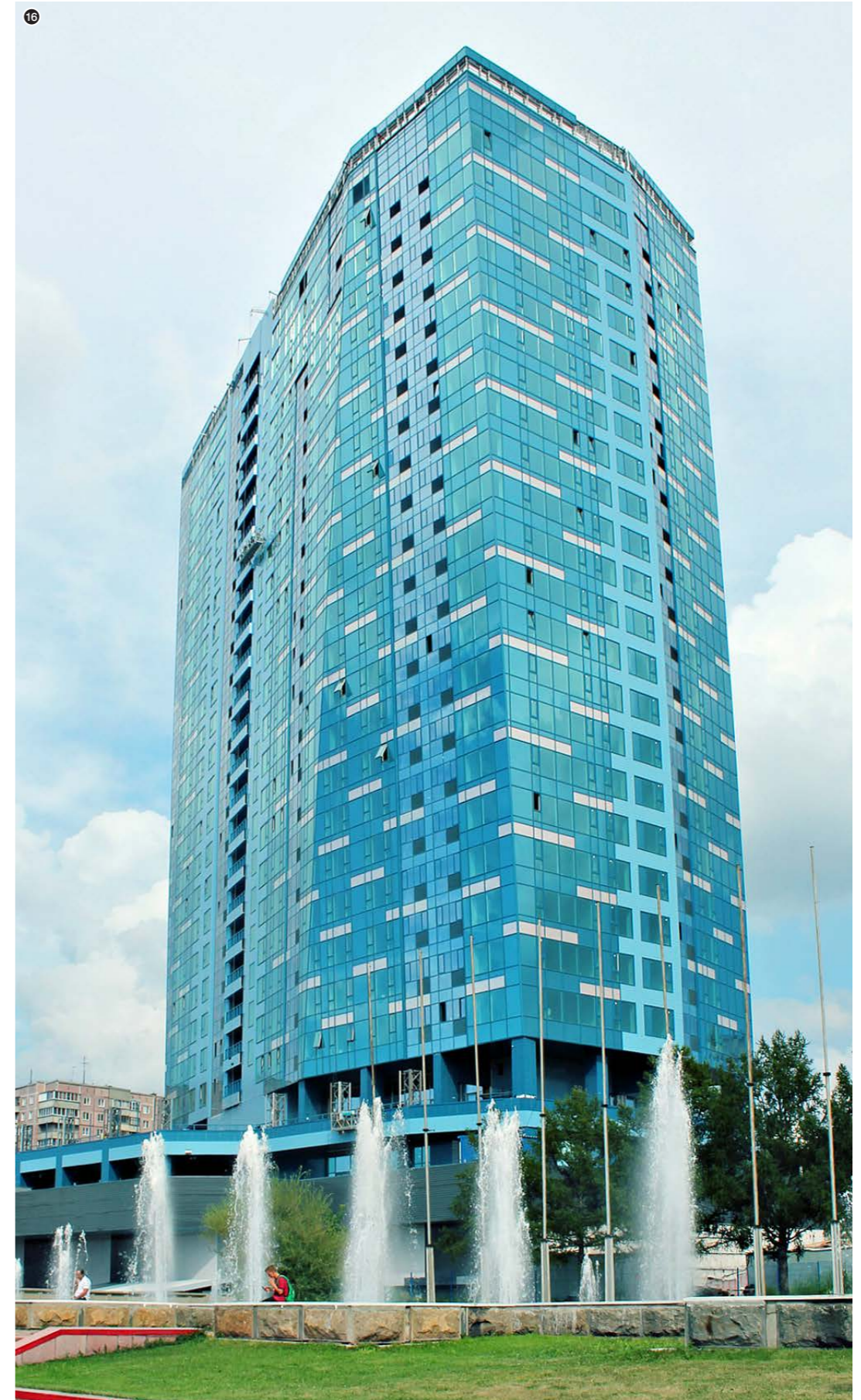
16. Жилой комплекс "Статус". Ул. Шевченко. Застройщик: ЗАО «Строитель». Отопление, водоснабжение: KAN-therm Push
