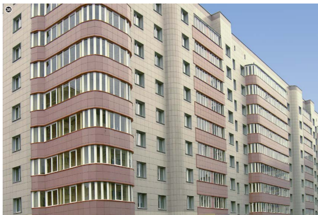
37. Жилой дом. Ул. Военная. Застройщик: Новосибирскжилстрой 2. Отопление: KAN-therm Push 38. Жилой дом. Ул. Выборная, 154. Застройщик: ВВ МВД РФ. Отопление: KAN-therm Push
