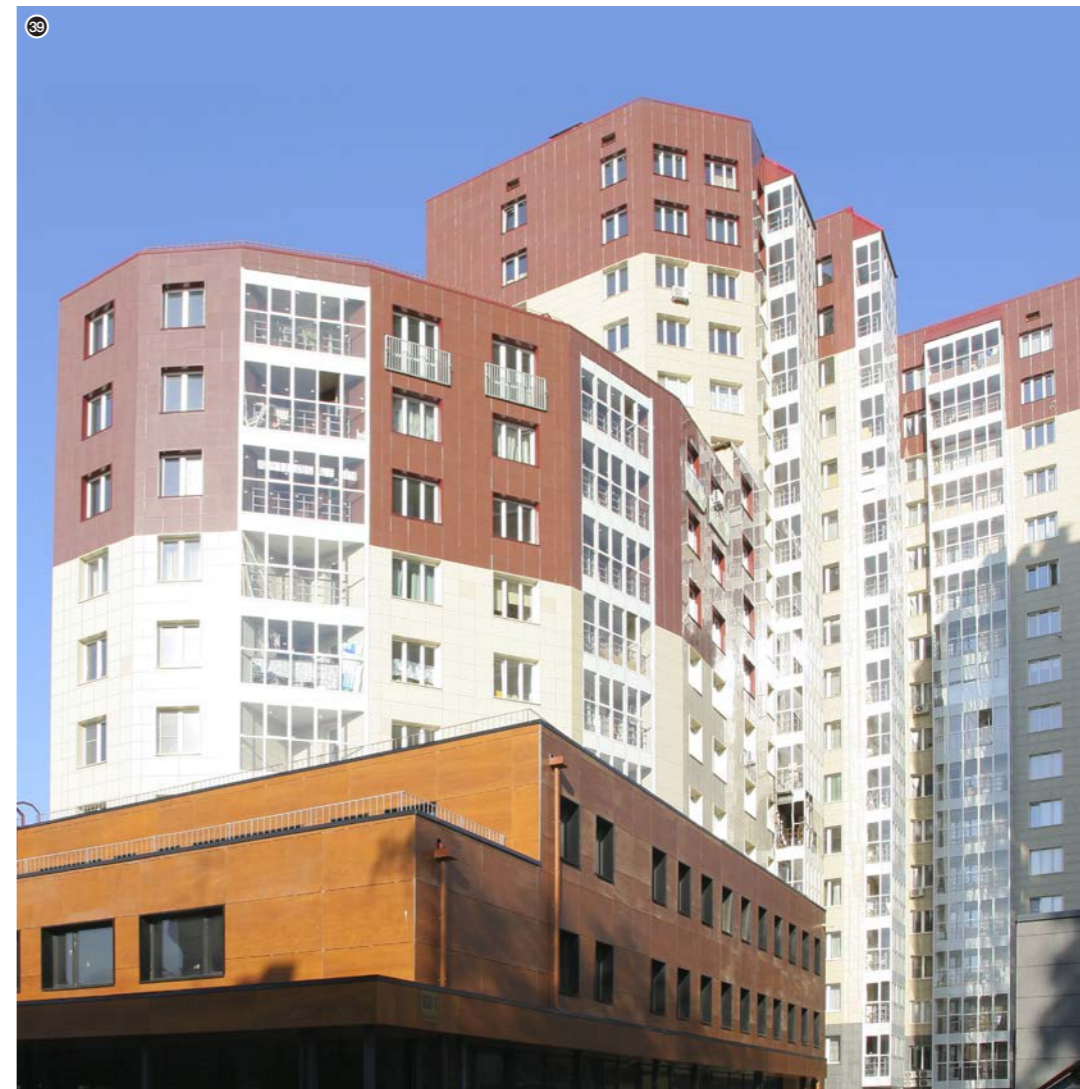
39. Жилой дом. Ул. Некрасова, 63. Застройщик: «Баутехник». Отопление: KAN-therm Push
