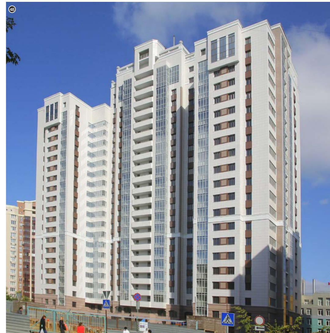
48. Жилой дом. Ул. Семьи Шамшиных. Застройщик: ГК "Кварсис". 2013 год. Отопление: KAN-therm Push
