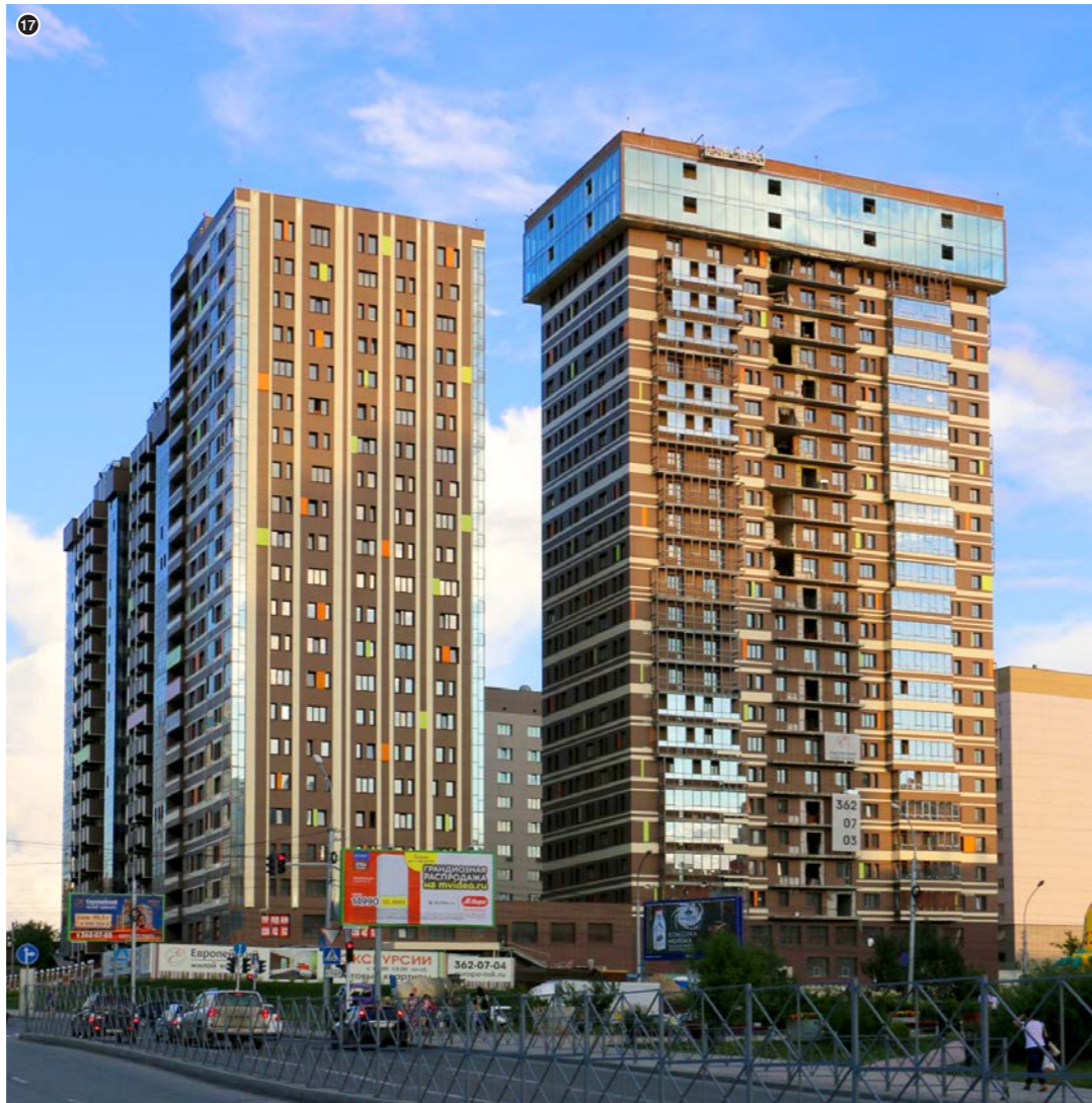
17. Жилой комплекс "Европейский". ул. Военная, 9. Застройщик: ГК "Металприбор". Отопление. KAN-therm Push
