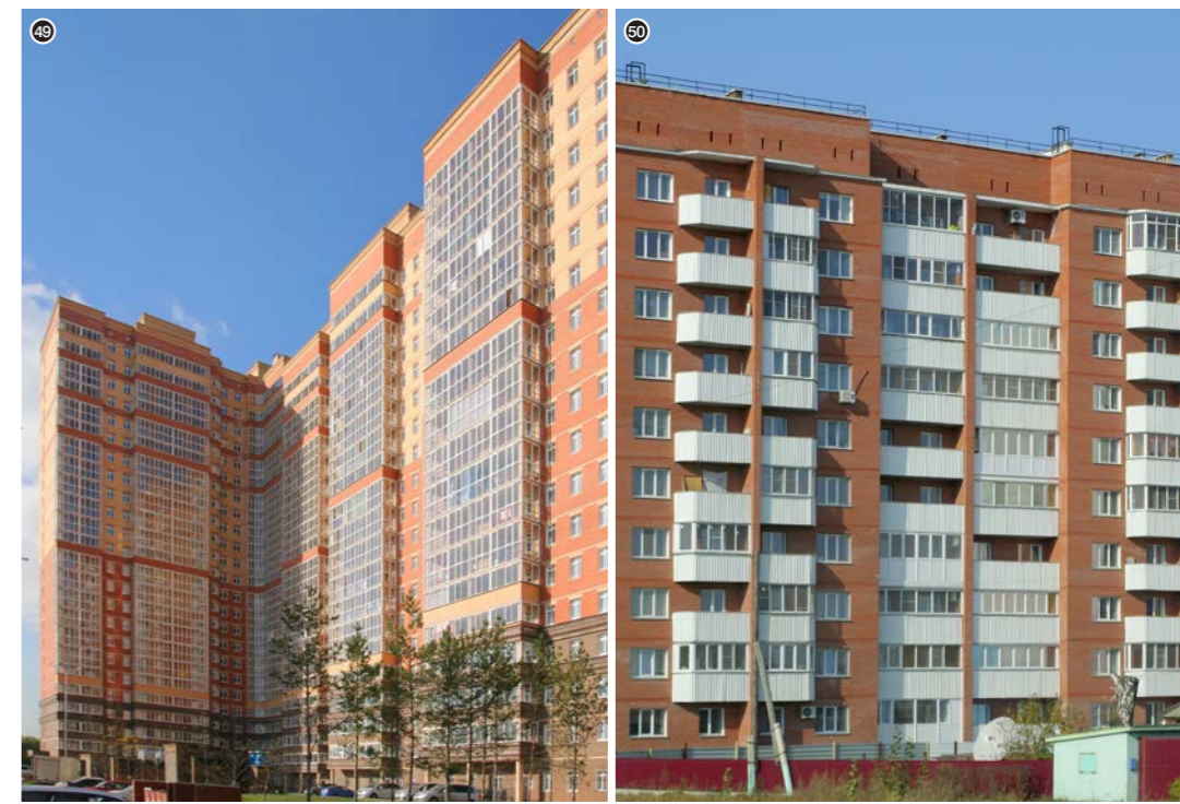
49. Жилой дом. Ул. Гребенщикова, 417 Застройщик: Энергомонтаж. Отопление, водоснабжение: KAN-therm Push 50. Жилой дом. Ул. Ломоносова. Застройщик: Баутехник. Отопление, водоснабжение: KAN-therm Push
