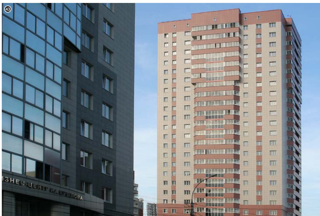
43. Жилой дом. Ул. Шамшиных, 71. Застройщик: Краснообск Монтажеспецстрой. Отопление, водоснабжение: KAN-therm Push
