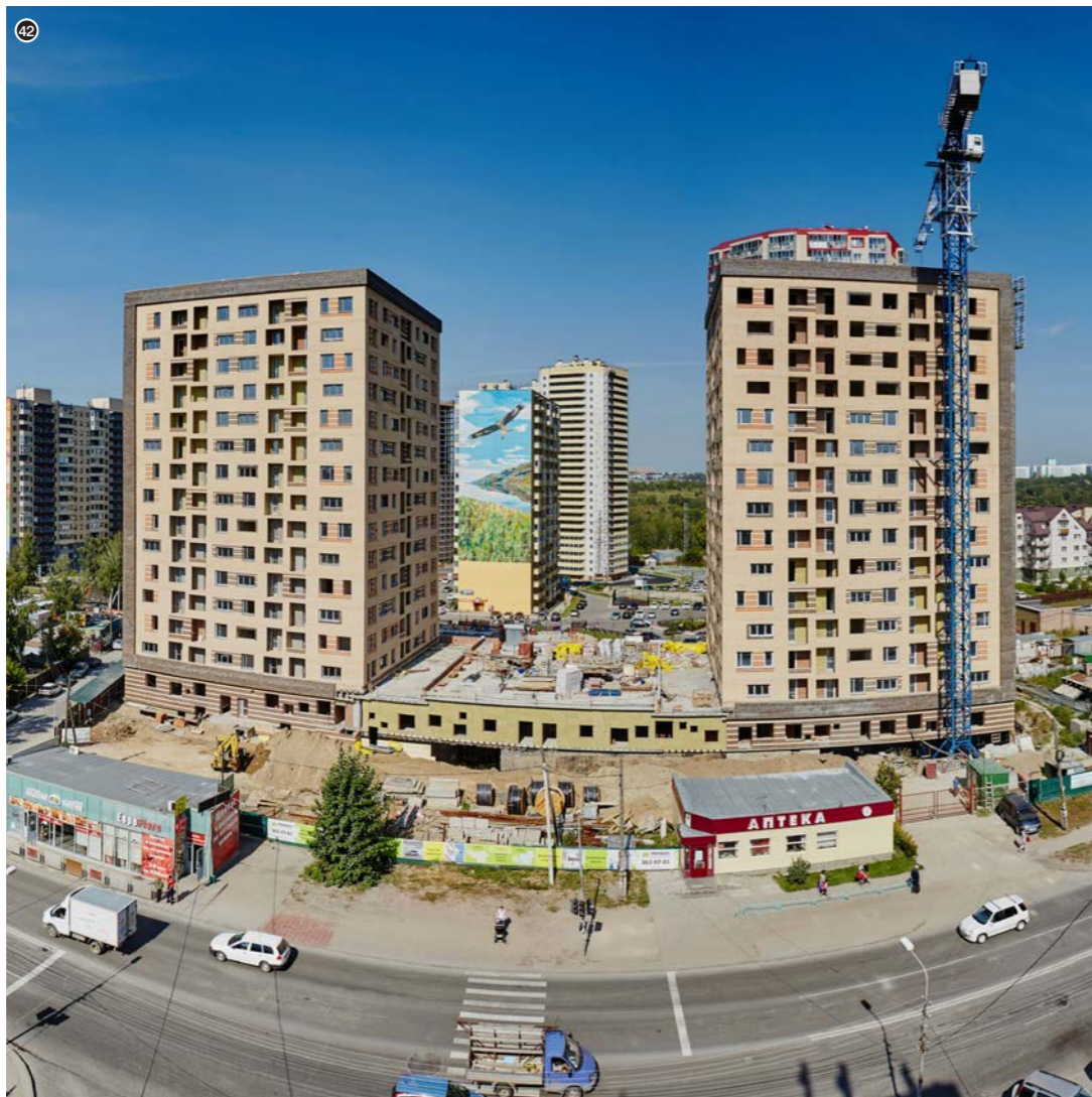
42. Жилой комплекс "Гринвилл". Ул. Вилейская. Застройщик: ГК "Металприбор". Отопление: KAN-therm Push
