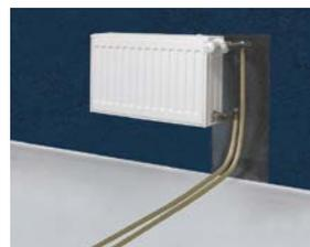
из стены – подключение одностороннее
