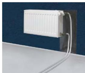
из стены при помощи соединителей Press с пресс-кольцом с наружной резьбой
